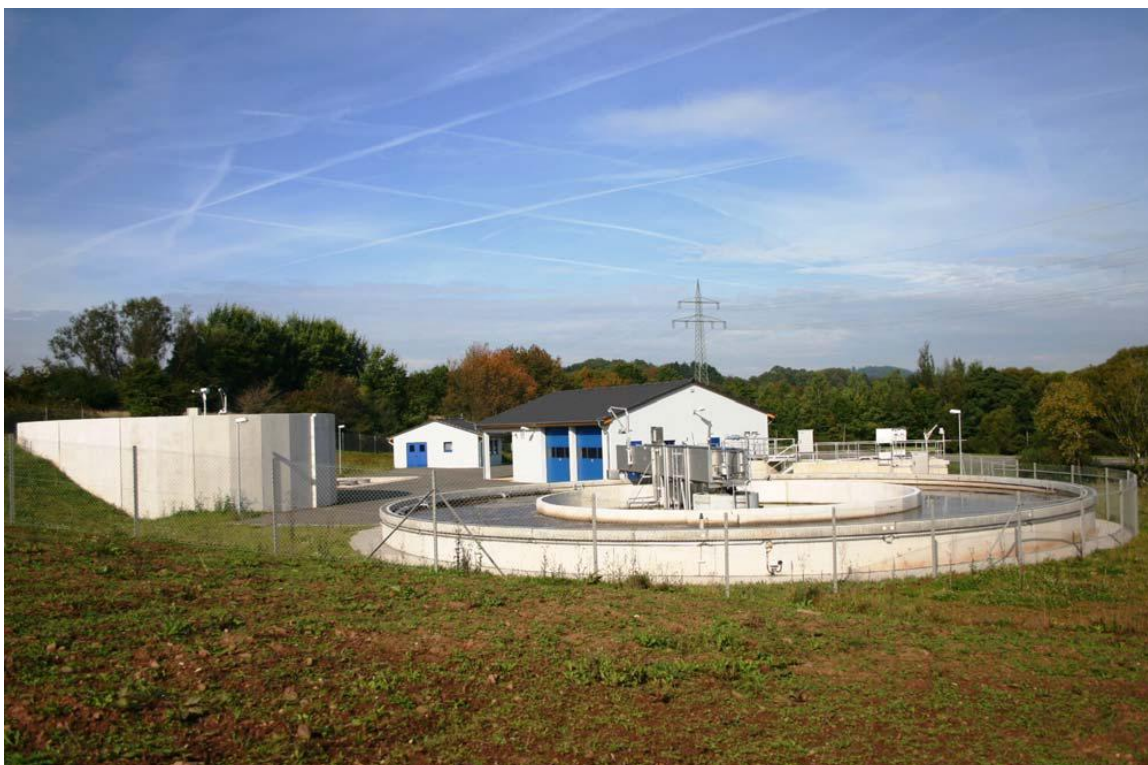
primjer bio-pročistača za 5.500 ekvivalentnih stanovnika
