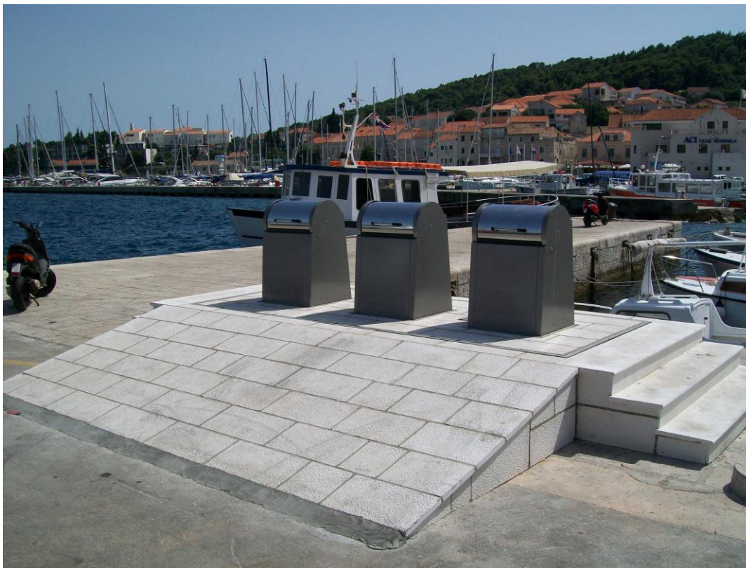
Komplet podzemnih kontejnera sa tri kontejnera – Obala V. Paletina
